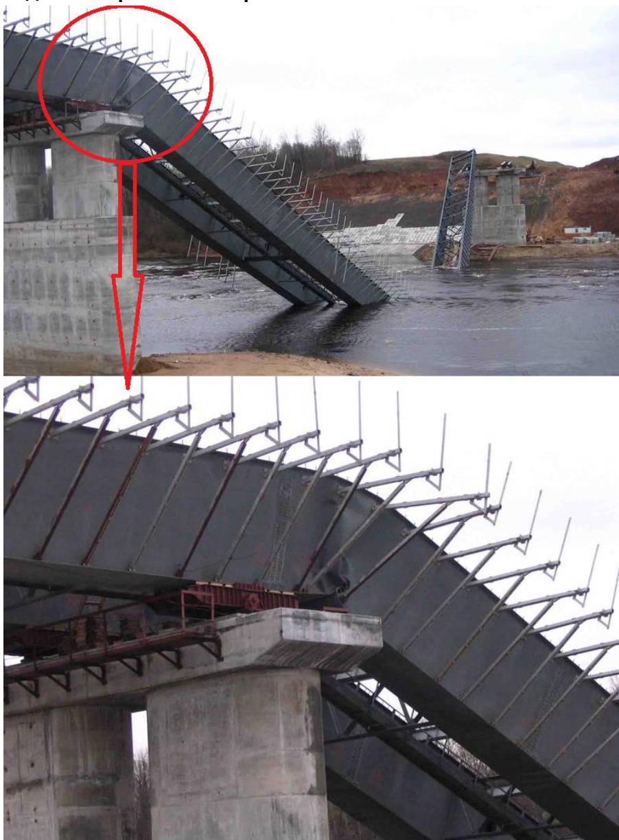
Рис. 153. Сложилась стенка над опорой при надвижке 128-метрового пролета моста через реку Западная Двина на юго-западном обходе Витебска. Декабрь 2006 г.
